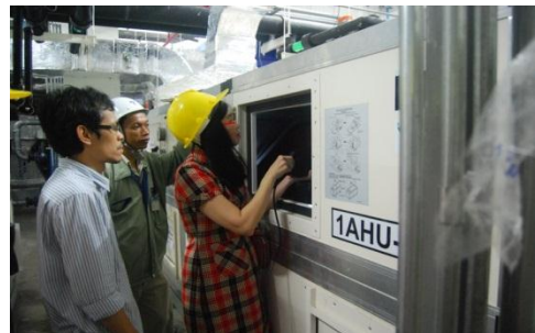
การตรวจวัดความเร็วของมอเตอร์ ในการขับเคลื่อนพัดลมของระบบอากาศ
