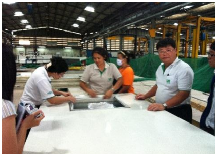
การตรวจสอบผนัง (Sandwich Panel) ณ โรงงานผู้ผลิตก่อนส่งมาดำเนินการติดตั้ง
